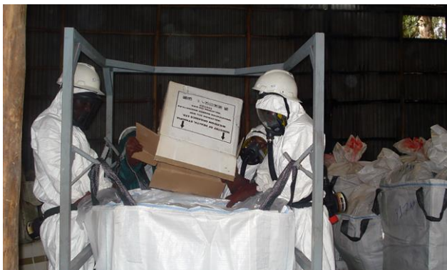
Figura 20 Empaquetado de contaminados con PCB
