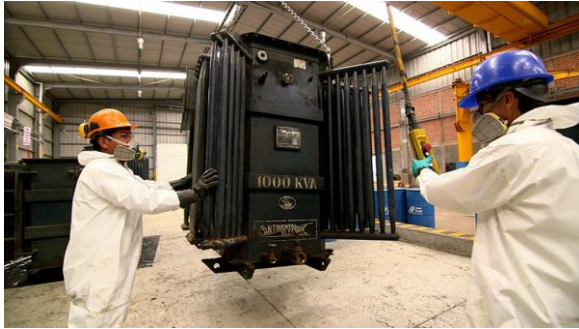
Figura 19 Remoción de transformadores con PCB
